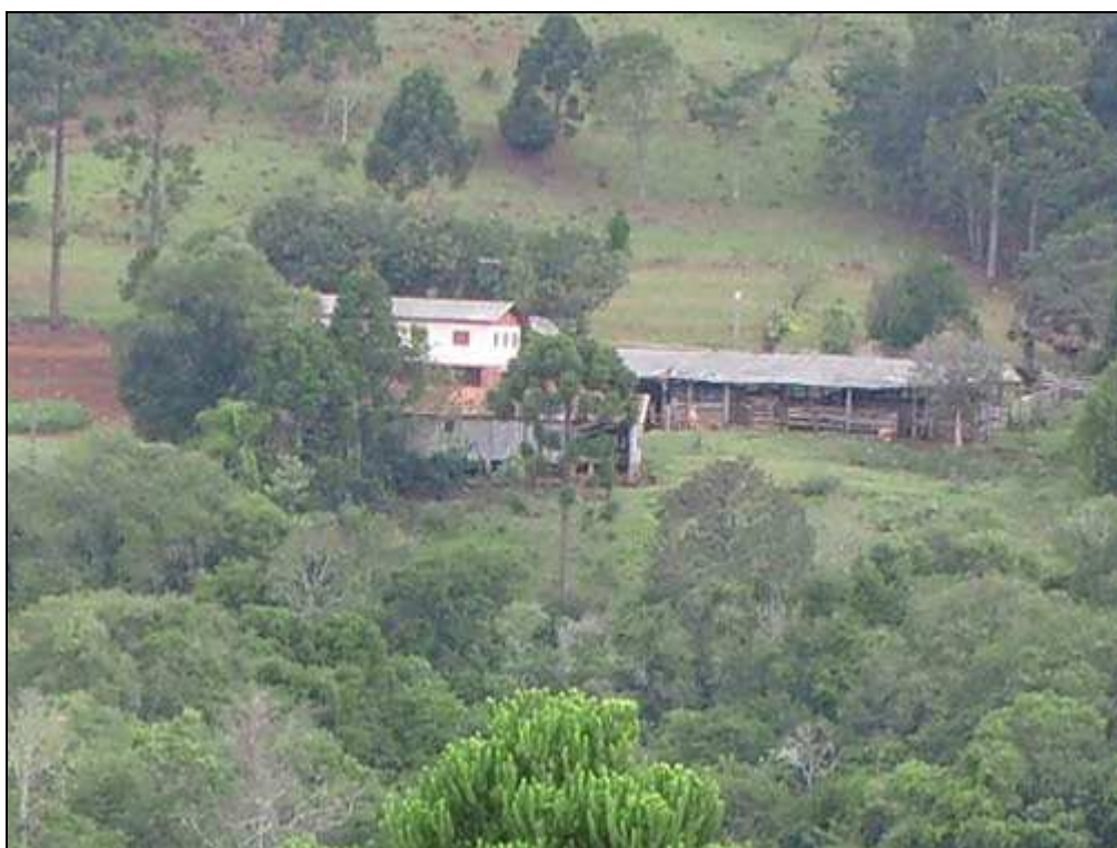
Foto 36: Casa no entorno do empreendimento. Crédito: Clotilde Zai (2009). Coordenadas UTM: 306640,28 O; 7117815,31 S (Fuso 22-Sul).
