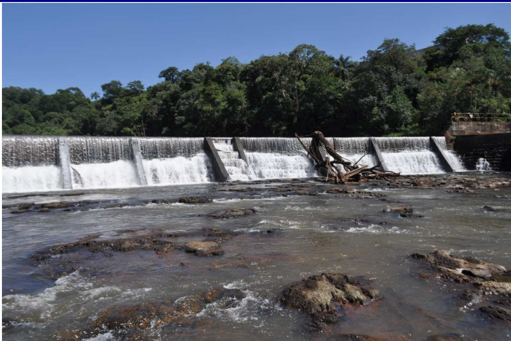
Foto 42: Vista frontal da barragem existente. Ao centro pode ser observada a escada para peixes.
