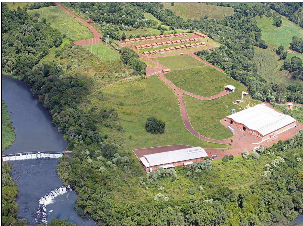
Foto 28: Sede da Alcast do Brasil Ltda. Crédito: Alcast do Brasil Ltda. Coordenadas UTM: 306157,45 O; 7118643,45 S (Fuso 22-Sul).
